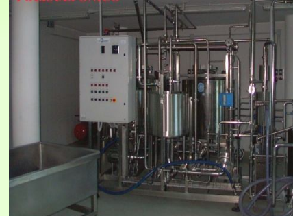
PSTMOL-LAB.CASEARIO DA SINISTRA IMPIANTO DI PASTORIZZAZIONE E SERBATOIO DI RICEVIMENTO
